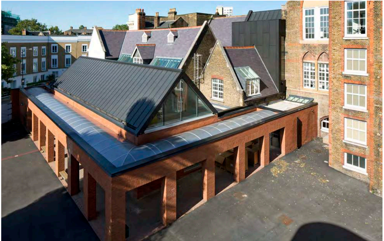
2012 / Extension réfectoire et passage couvert - Canteen and covered walkway extension
